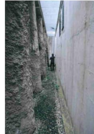
Stützmauer PI zum Hag
